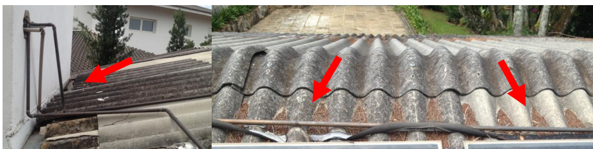
Figura 3.5 – Tubulação sem Estrutura de Apoio e Isolamento Térmico Inoperante Fonte: Autor
