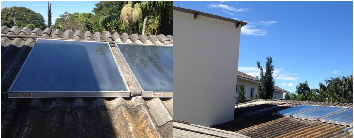
Figura 3.6 – Sombreamento Proveniente de Construção Fonte: Autor
