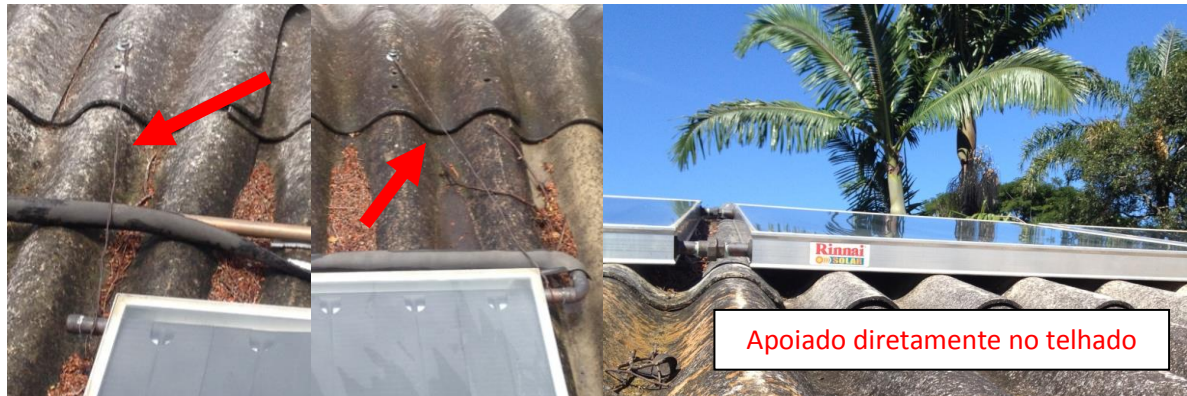
Figura 3.4 – Fixação dos Coletores Solares Fonte: Autor
